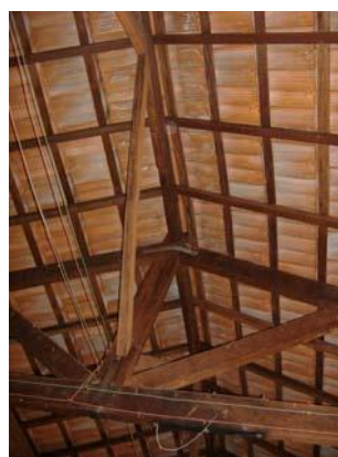
Foto 09- Engradamento do telhado e telhas do salão/ palco. Município de Itapagipe - MG Raquel Córdova Christófaro, abril/ 2010
