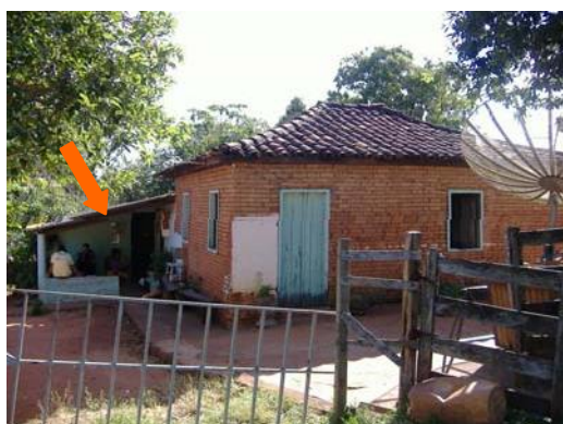
Foto 01- Fachada frontal, detalhe da construída há 45 anos. Município de Itapagipe - MG Raquel Córdova Christófarro, abril/ 2010
