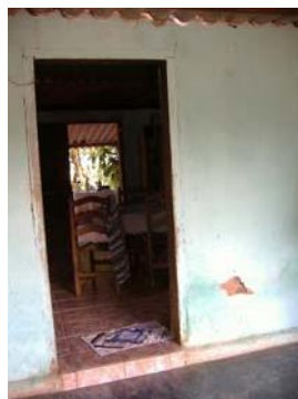
Foto 09- Vista da porta da cozinha, detalhe do piso e desprendimento do reboco. Município de Itapagipe - MG Raquel Córdova Christófaro, abril/ 2010
