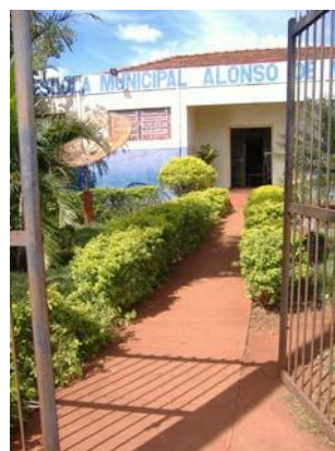
Foto 02- Detalhe do piso e portão de acesso a escola. Município de Itapagipe - MG Raquel Córdova Christófar , abril/ 2010
