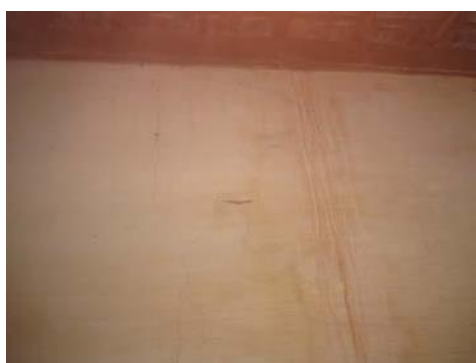
Foto 11- Detalhe da parede com mancha provocada pela infiltração de água de chuva. Município de Itapagipe - MG Raquel Córdova Christófaro, abril/ 2010
