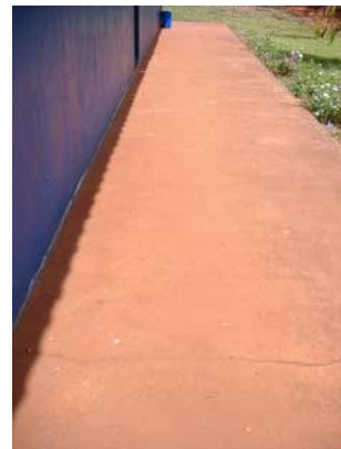
Foto 25- Piso externo às salas de aula, segunda edificação, apresentando trinca. Município de Itapagipe - MG Raquel Córdova Christófaro, abril/ 2010
