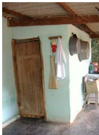
Foto 11- Vista do acesso ao banheiro. Município de Itapagipe - MG Raquel Córdova Christófaro, abril/ 2010
