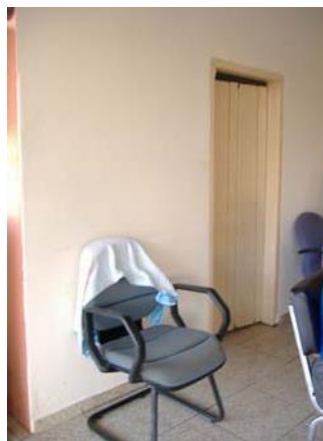
Foto 09- Vista da porta de acesso ao banheiro, detalhe do acabamento de parede e piso cerâmico. Município de Itapagipe - MG Raquel Córdova Christófaro, abril/ 2010
