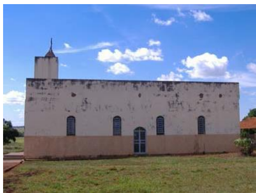
Foto 04- Fachada lateral esquerda, detalhe do desprendimento da pintura e manchas causadas por umidade.
