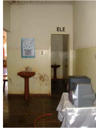
Foto 11- Detalhe do acesso ao banheiro masculino, desgaste da pintura. Município de Itapagipe - MG Raquel Córdova Christófaro, abril/ 2010
