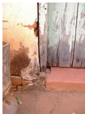
Foto 05- Detalhe madeira da porta e da alvenaria. Município de Itapagipe - MG Raquel Córdova Christófaro, abril/ 2010
