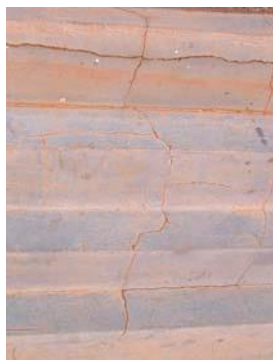
Foto 06- Detalhe do piso da escada de acesso à igreja apresentando trincas e desgaste da pintura.
