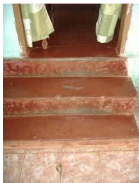
Foto 08- Detalhe do piso da cozinha e da sala. Município de Itapagipe - MG Raquel Córdova Christófaro, abril/ 2010
