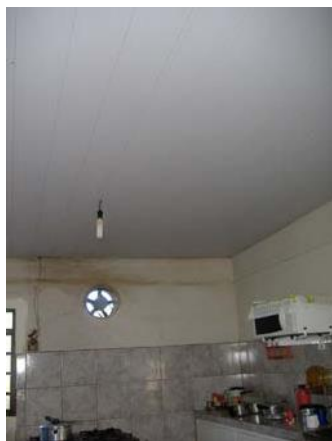
Foto 08- Vista da cozinha, detalhe do forro de PVC Município de Itapagipe - MG Raquel Córdova Christófaro, abril/ 2010
