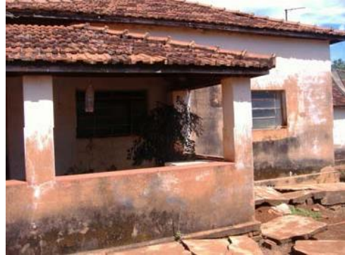
Foto 07- Detalhes: piso do entorno da casa, musgo em decorrência da infiltração por capilaridade, desprendimento da pintura e substituição da cobertura para telha plana. Município de Itapagipe - MG Raquel Córdova Christóforo, abril/ 2010
