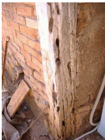
Foto 06- Detalhe do esteio com ataque de xilófagos. Município de Itapagipe - MG Raquel Córdova Christófaro, abril/ 2010
