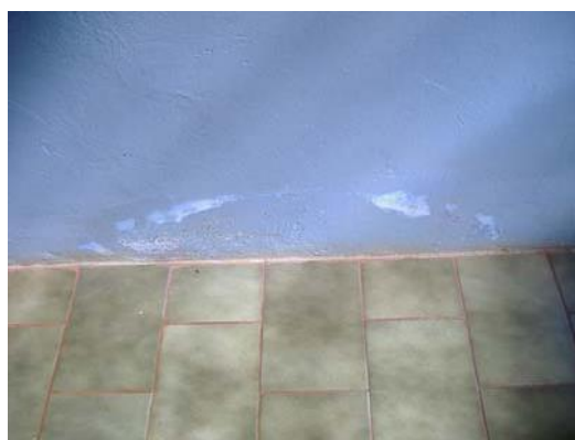
Foto 15- Detalhe do piso interno. Município de Itapagipe - MG Raquel Córdova Christófaro, abril/ 2010
