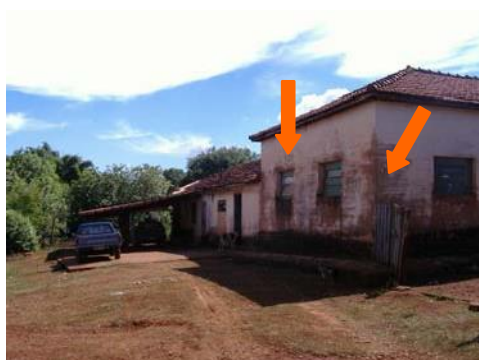
Foto 05- Fachada lateral esquerda - detalhe desprendimento da pintura e substituição do fechamento das janelas.
