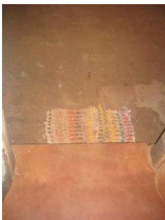
Foto 07- Detalhe piso cimentado liso externo (natural) e interno (vermelho). Município de Itapagipe - MG Raquel Córdova Christóforo, abril/ 2010
