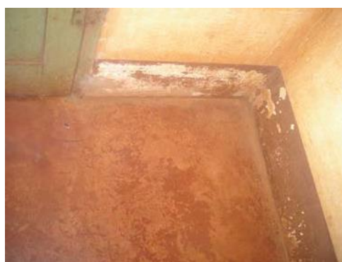
Foto 12- Detalhe do piso e rodapé com a pintura descascada. Município de Itapagipe - MG Raquel Córdova Christófaro, abril/ 2010
