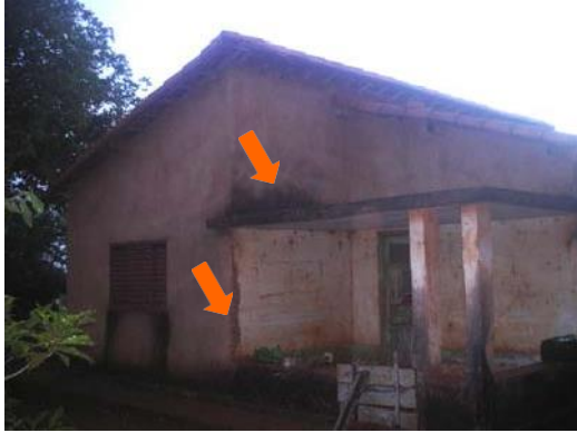
Foto 03- Detalhe da fachada frontal, desprendimento da pintura, manchas e sujidades. Município de Itapagipe - MG Raquel Córdova Christóforo, abril/ 2010
