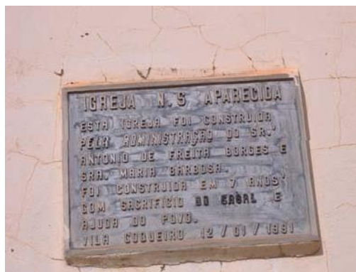
Foto 07- Placa instalada na fachada frontal, detalhe da trinca e conseqüente desprendimento da pintura.
