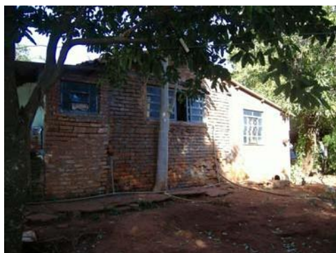
Foto 04- Fachada posterior – janelas comesquadria metálica e vidro. Município de Itapagipe - MG Raquel Córdova Christófaro, abril/ 2010
