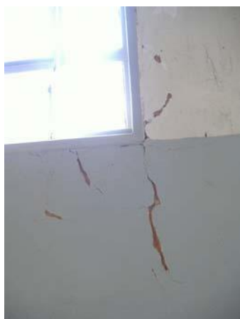
Foto 14- Desprendimento da pintura e do reboco interno. Município de Itapagipe - MG Raquel Córdova Christófaro, abril/ 2010
