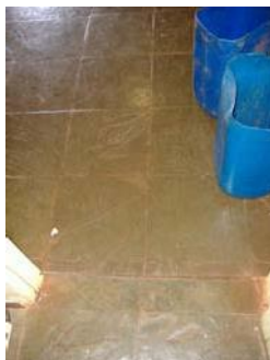
Foto 14- Detalhe do piso em ardósia da cozinha. Município de Itapagipe - MG Raquel Córdova Christófaro, abril/ 2010
