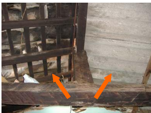
Foto 06- Detalhe da cobertura da cozinha, substituição da telha. Município de Itapagipe - MG Raquel Córdova Christófaro, abril/ 2010
