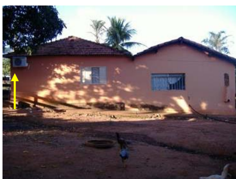
Foto 04- Fachada lateral esquerda – detalhe das janelas e do aparelho de ar condicionado. Município de Itapagipe - MG Raquel Córdova Christófaro, abril/ 2010
