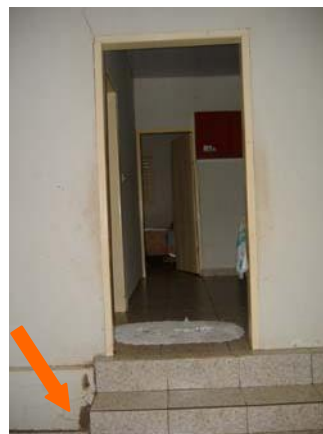
Foto 07- Detalhe do piso cerâmico, desprendimento do reboco e trincas na pintura. Município de Itapagipe - MG Raquel Córdova Christófaro, abril/ 2010
