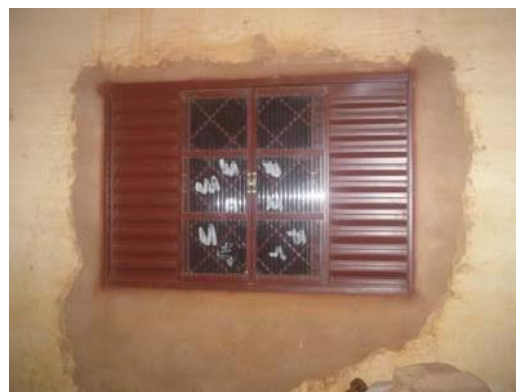
Foto 08- Detalhe da janela e a nova esquadria metálica. Município de Itapagipe - MG Raquel Córdova Christóforo, abril/ 2010
