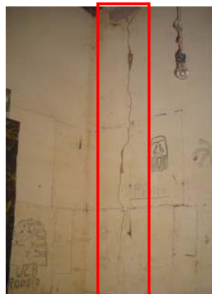
Foto 10- Detalhe da parede interna apresentando manchas e trincas. Município de Itapagipe - MG Raquel Córdova Christófaro, abril/ 2010
