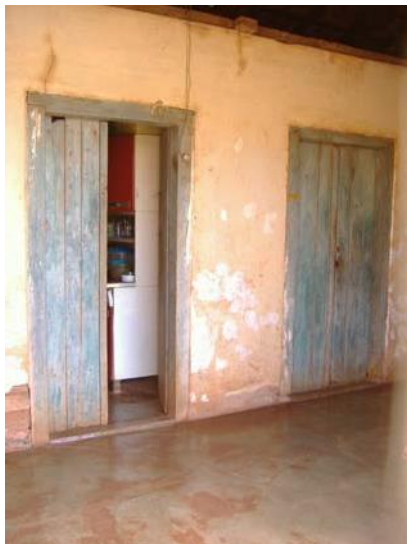
Foto 08- Detalhes: portas internas (originais) com desprendimento da pintura e alvenaria com desprendimento do reboco e pintura. Piso cimentado liso com manchas e sujidades. Município de Itapagipe - MG Raquel Córdova Christóforo, abril/ 2010
