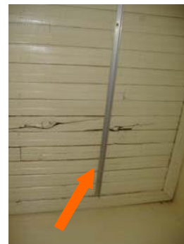
Foto 15- Detalhe do forro de madeira apresentando rachadura e perfil de alumínio para sustentação do mesmo. Município de Itapagipe - MG Raquel Córdova Christófaro, abril/ 2010
