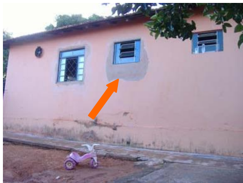
Foto 06- Fachada posterior – detalhe substituição das esquadrias e diminuição dos vãos. Município de Itapagipe - MG Raquel Córdova Christófaro, abril/ 2010
