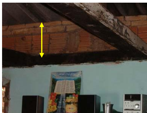
Foto 07- Detalhe do aumento da alvenaria para construção da varanda na fachada lateral direita. Município de Itapagipe - MG Raquel Córdova Christófaro, abril/ 2010
