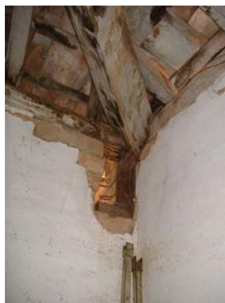
Foto 09- Detalhe do encontro da alvenaria com o engradamento do telhado. Município de Itapagipe - MG Raquel Córdova Christófaro, abril/ 2010
