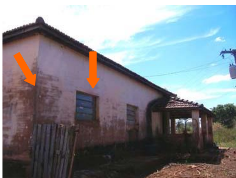
Foto 04- Fachada frontal – detalhe do desprendimento da pintura e substituição do fechamento das janelas.
