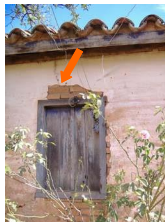
Foto 05- Detalhe despreendimento do reboco e da pintura. Município de Itapagipe - MG Raquel Córdova Christófaro, abril/ 2010
