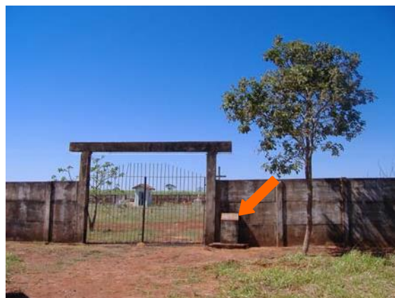
Foto 01- Vista do portal de entrada do cemitério. A seta indica o local de instalação da placa de inauguração.
