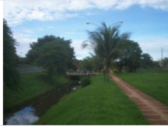
Foto 03- Córrego Lageado - Calha fluvial, foto tirada da montante, vista da passarela, ponte e muro. Perímetro Urbano. Município de Itapagipe - MG. Adriano Breguncci Pontello
