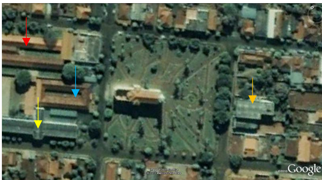
Imagem 31 – Vista aérea da Praça da Matriz (com o Norte deslocado), retirada do programa Google Earth em agosto de 2011. No centro da imagem temos a Igreja Matriz de Santo Antônio, circundada pela praça. A seta amarela mostra a sede administrativa municipal. A seta azul mostra a Escola Municipal “Gil Brasileiro da Silva”. A seta vermelha destaca a Escola “Alonso de Moraes” e a seta laranja mostra o prédio do Banco do Brasil
