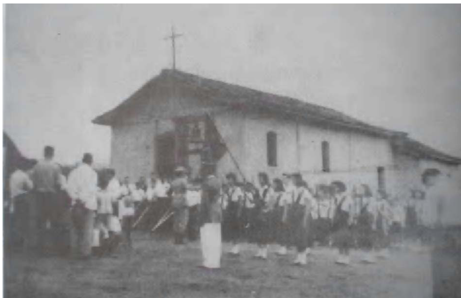
Imagem 03 – Fotografia da antiga Capela de Santo Antônio do Lageado, erigida na margem direita do córrego de mesmo nome. A primeira ermida em louvor ao santo padroeiro, na verdade uma choupana, foi erguida na margem esquerda desse rio, região que se mostraria inadequada. A capela definitiva então seria construída na margem oposta.
